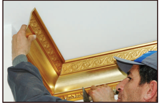
Decolux iç köşe uygulamaları
